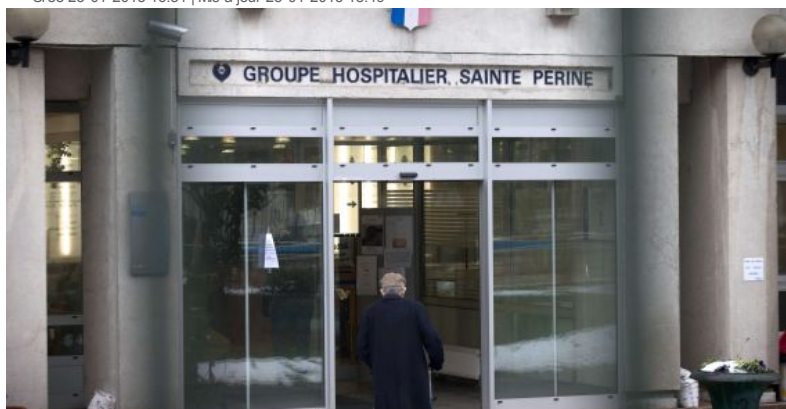
L'hôpital Sainte-Périne, situé 11, rue Chardon-Lagache dans le 16e est spécialisé en gériatrie. Photo : AFP
