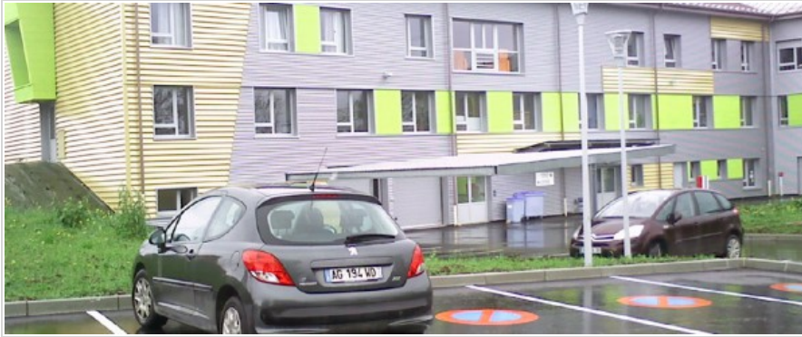
Les lits médicalisés du nouvel Ehpad (Etablissement d'hébergement pour personnes âgées dépendantes), pourtant flambant neuf, ne sont pas opérationnels.
